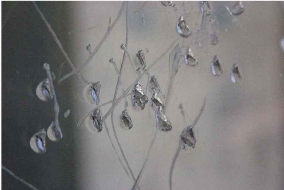
Bild 3 Schäden aus der manuellen Prüfung nach RC2
