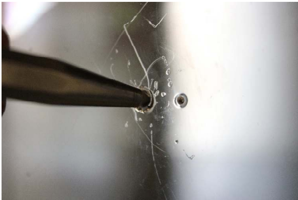
Bild 2 Schäden aus der manuellen Prüfung nach WK3
